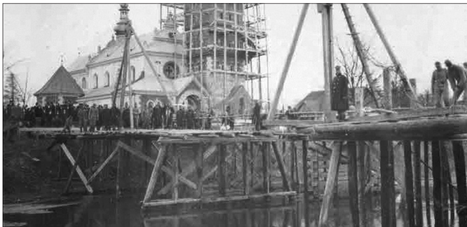
Budowa mostu, marzec 1915.
