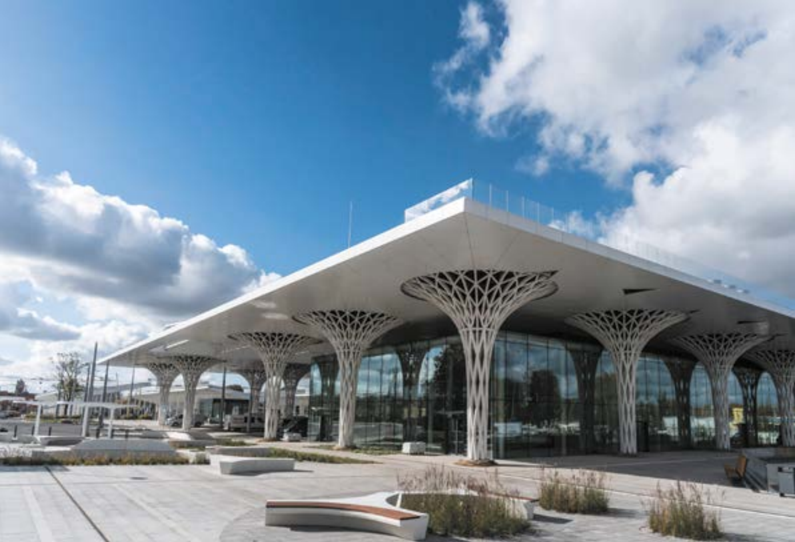
Dworzec Lublin – budynek zachwyca nowoczesnością, funkcjonalnością i zastosowanymi rozwiązaniami technicznymi. Fot. Urząd Marszałkowski Województwa Lubelskiego
