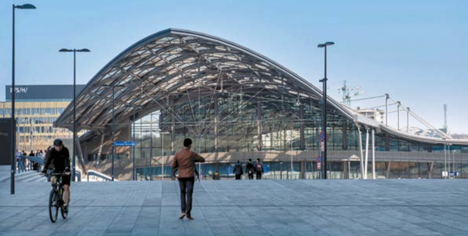
Budynek multimodalnego dworca Łódź Fabryczna.
