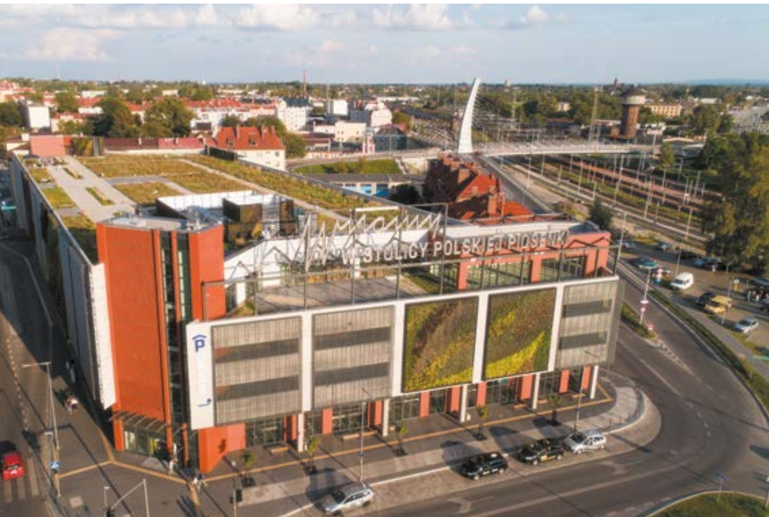
Centrum przesiadkowe w Opolu.
